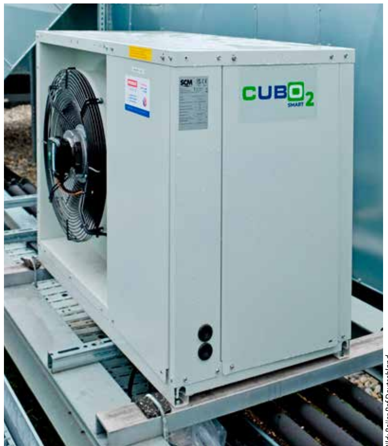
Die SCM Frigo Cubo 2 Smart auf dem Dach
