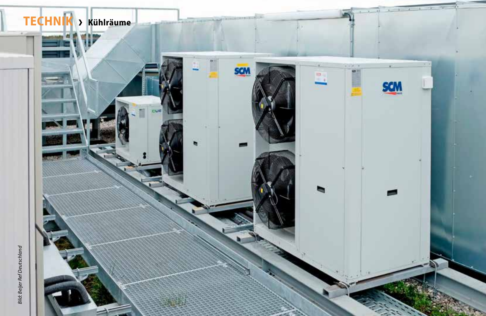
Verflüssigungssätze von SCM Frigo auf dem Dach: Cubo 2 Smart (ganz links) und zwei Cubo 2 Plus (Mitte und rechts)
