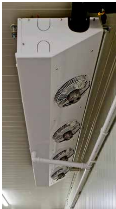
Luftkühler/Verdampfer (Roller) im Lagerraum
